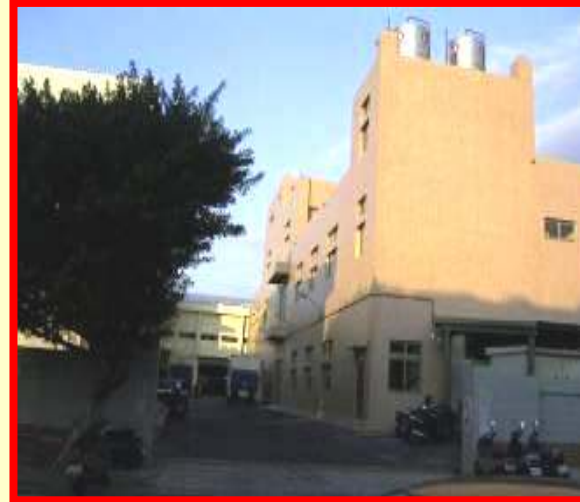
世禾二廠：土地面積：994坪 新竹縣湖口鄉新竹工業區復興路30號
